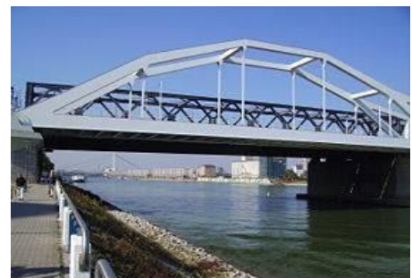
Puente fabricado de acero
